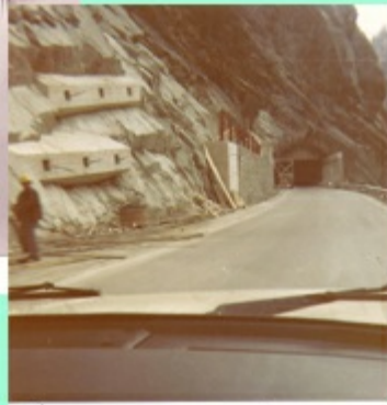
Forarbejde til overdækn. m. sne/sten
